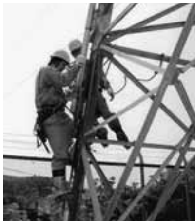
現場実習風景（送電線鉄塔作業）
