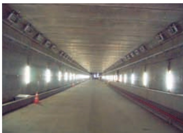
坑内照明器具取り付け状況
