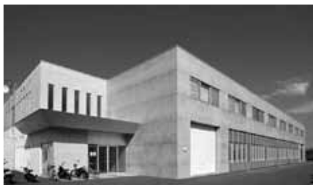
電気・電子系の実習棟
