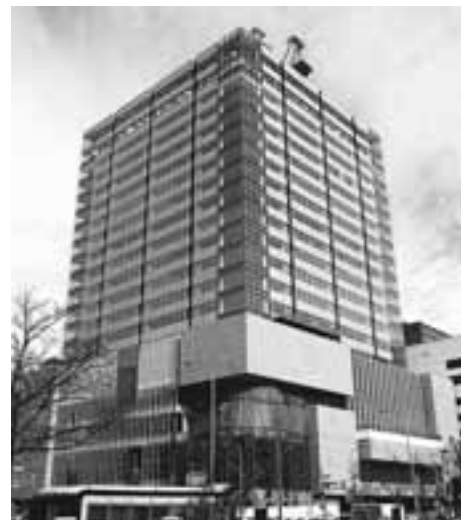
工事中の北洋大通センタービル
