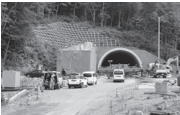
トンネル坑口（古平側）
