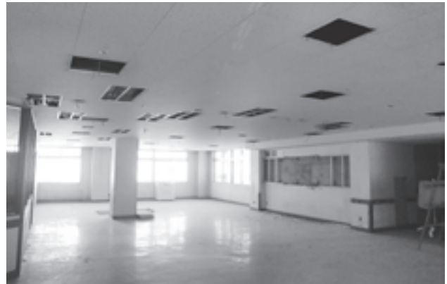
B棟 室内照明器具撤去状況
