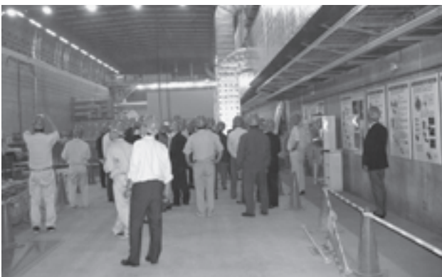
地下400mの広大な空間にある発電所本館
