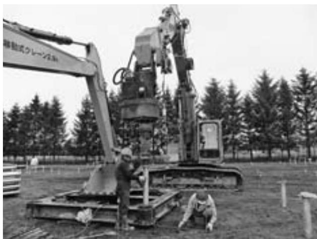
スクリー式鋼管杭を重機で打ち込む作業
