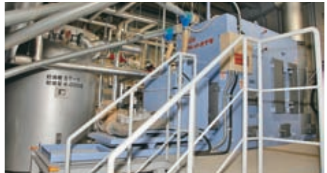
なんぼろ温泉に設置したペレットボイラー
