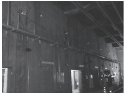
1階 配管露出化
