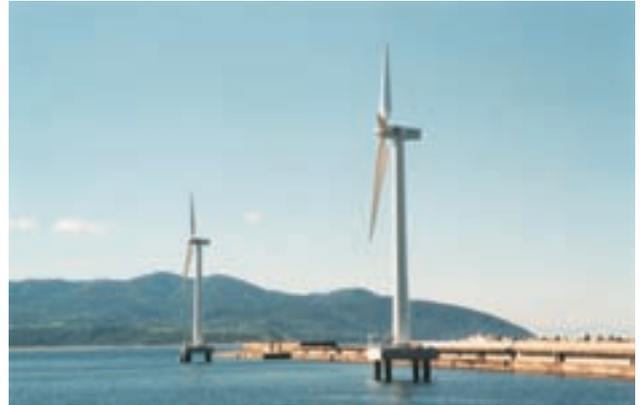
日本で初めて海の上に建設されて本格稼働した風車。日本海から吹く強い風をエネルギーに変えようというプロジェクトが始まり、平成15年10月に試運転開始。11月から送電を開始し、翌年4月から本格稼働。2基の風車の出力は600kW。
