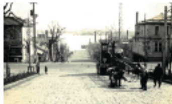
昭和30年代の八幡坂の電気工事
