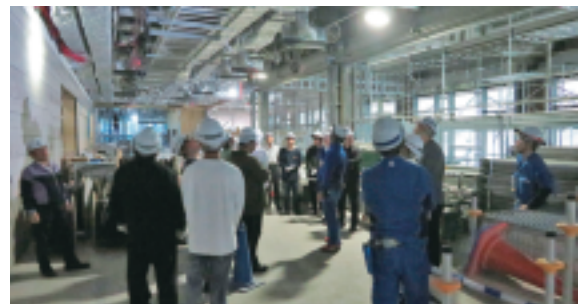
防火シャッターや関連設備の説明を受ける
