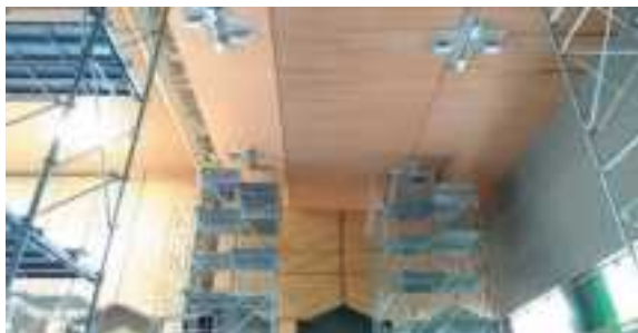
枠組み足場での作業
