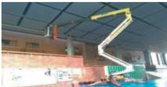
高所作業車での作業
